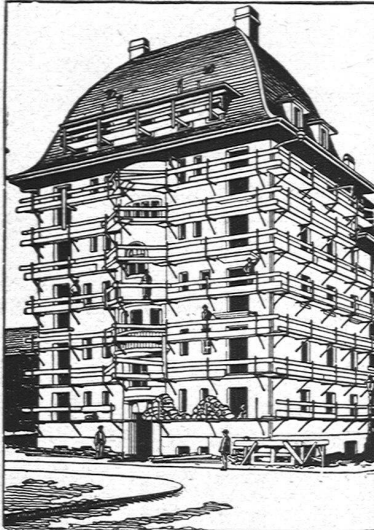
Ansicht eines eingerüsteten Hauses
