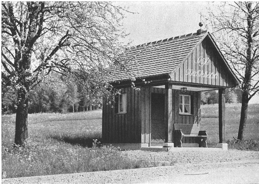
Architekten B. S. A. Kölla & Roth, Wädenswil. Wartehäuschen der elektrischen Straßenbahn Wetzikon-Meilen „Mühleholzli“
