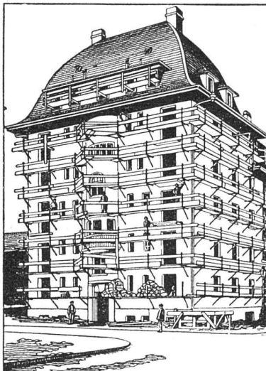
Ansicht eines eingerüsteten Hauses
