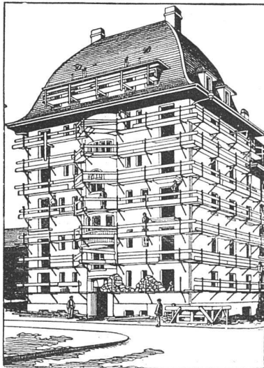
Ansicht eines eingerüsteten Hauses
