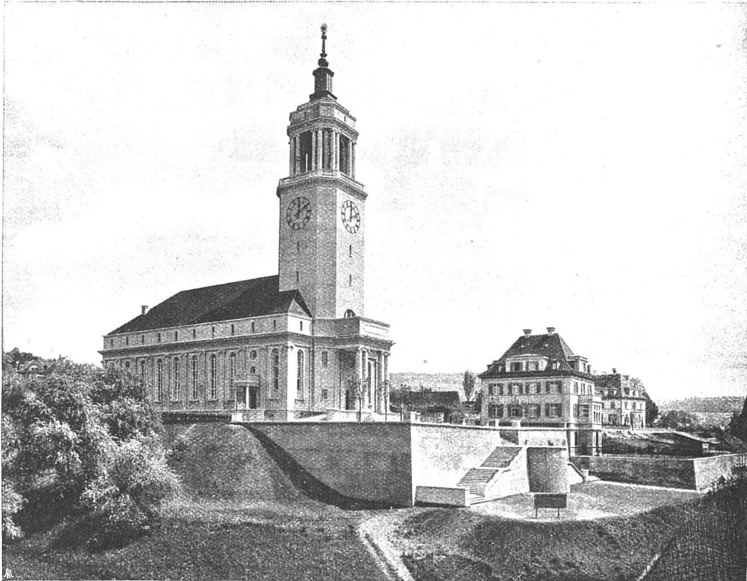
NEUE KIRCHE UND PFARRHAUS IN ZÜRICH-FLUNTERN
