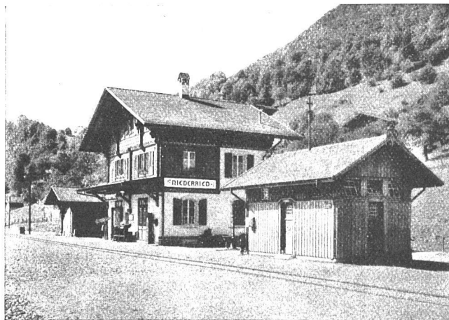
STATION DER BRIENZERSEEBAHN, ETERNIT-DOPPELDACH, KUPFERBRAUN
