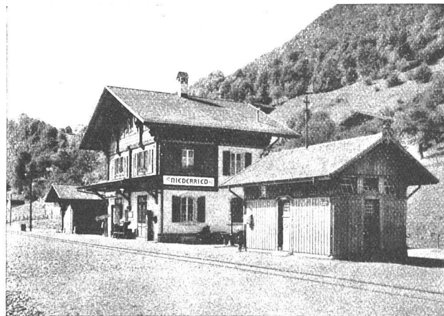
STATION DER BRIENZERSEEBAHN, ETERNIT-DOPPELDACH, KUPFERBRAUN
