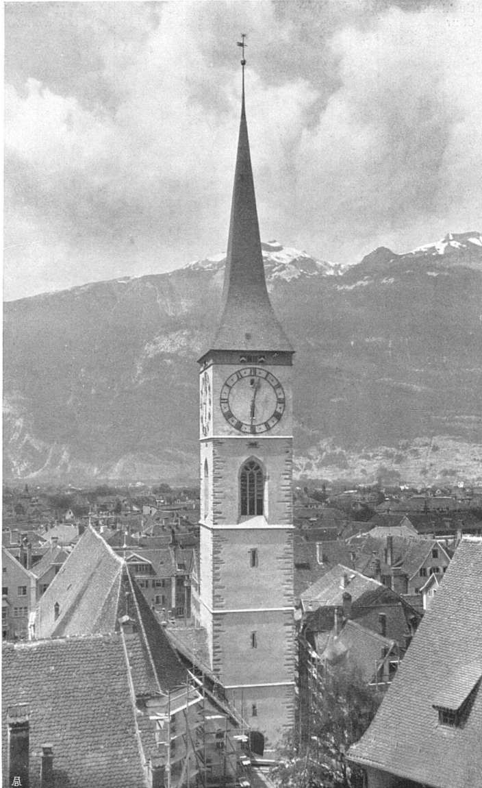
Turm erhöht und renoviert durch Schäfer & Risch Architekten B.S.A.
