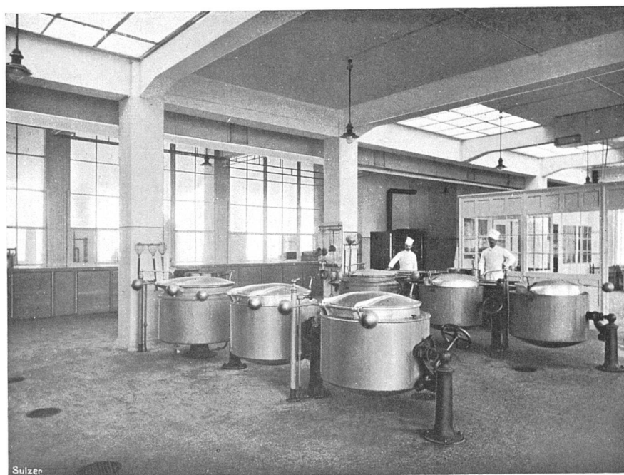
O b e n : Speisesaal für 600 Personen. Wandbemalung: Grund helles Blau, Aufteilung und Ornamente in hellem Rot, Decke und Säulen weiß, nach Angaben von Maler Paul Bodmer, Oetwil a. See. U n t e n : Dampfkochküche, betrieben durch Gliederkessel von 0,4 Atm. Arbeitsdruck, mit acht Dampfkochkesseln von zusammen 2100 Liter Inhalt. Wärmeschränke, Ventilation: Gebr. Sulzer Akt.-Ges., Abt. Zentralheizungen, Winterthur. Kühlanlagen: Escher, Wyß & Cie., Zürich. Heizung: Stehle & Gutknecht A.-G., Basel, Sulzer Zentralheizung. Elektrische Beleuchtung: Kümmler & Matter A.-G., Aarau. Spengler- und Installationsarbeiten: Ad. Häfeli & Sohn, Schönenwerd. Mobiliar: H. Woodtly & Co., Aarau. A.-G. Möbelfabrik Horgen-Glarus
