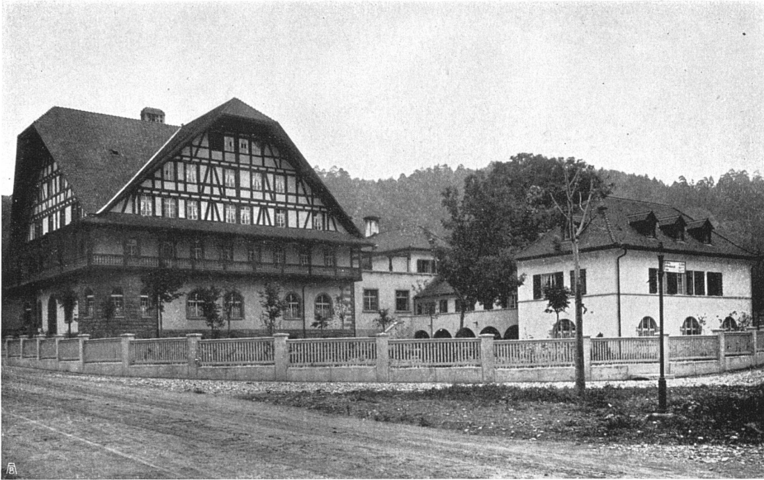
Logierhaus Birch der A.-G. Eisen- und Stahlwerke vorm. Georg Fischer, Schaffhausen. Projektaufstellung: Technisches Bureau der A.-G. Eisen- u. Stahlwerke Schaffhausen. Architektur u. Bauleitung: Arnold Meyer, Architekt Hallau. Bauarbeiten: Neidhart & Traber, Ramsen, Franz Rossi, J. Günther, E. Spahn, R. Heinemann, Schaffhausen
