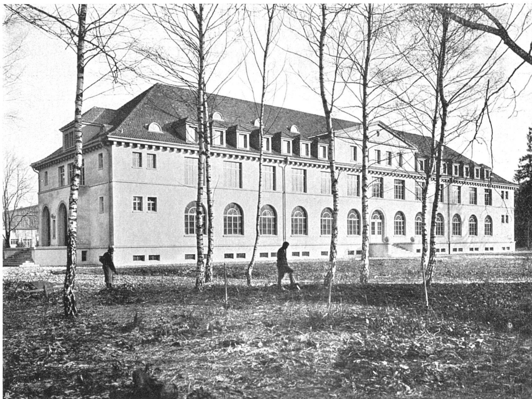
Kosthaus C. F. Bally A.-G., Schönenwerd. Entwurf: Professor Dr. K. Moser, Architekt S.W.B., Zürich. Bauleitung: Baubureau C. F. Bally, Schönenwerd, Architekt Amsler. Maurerarbeiten: Ad. Schäfer & Cie., Aarau. Zimmerarbeiten: Preiswerk & Cie., Basel. Schreinerarbeiten: Gebr. Bodmer, Hans Meier, Niedergösgen, Julius Frasculli, Schönenwerd, Ad. Schäfer & Cie., Aarau; Fenster: Friedr. Müllers Söhne, Glarus. Dachdeckerarbeiten: Casimir von Arx Söhne, Olten
