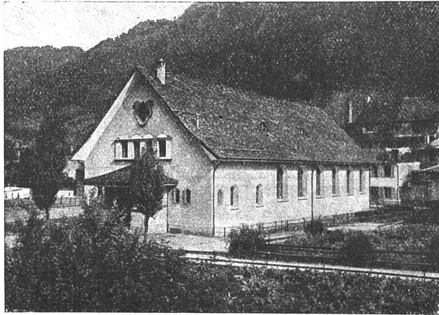
TURNHALLE IN GLARUS ETERNIT-DOPPELDACH, SCHWARZ ENGOBIERT
