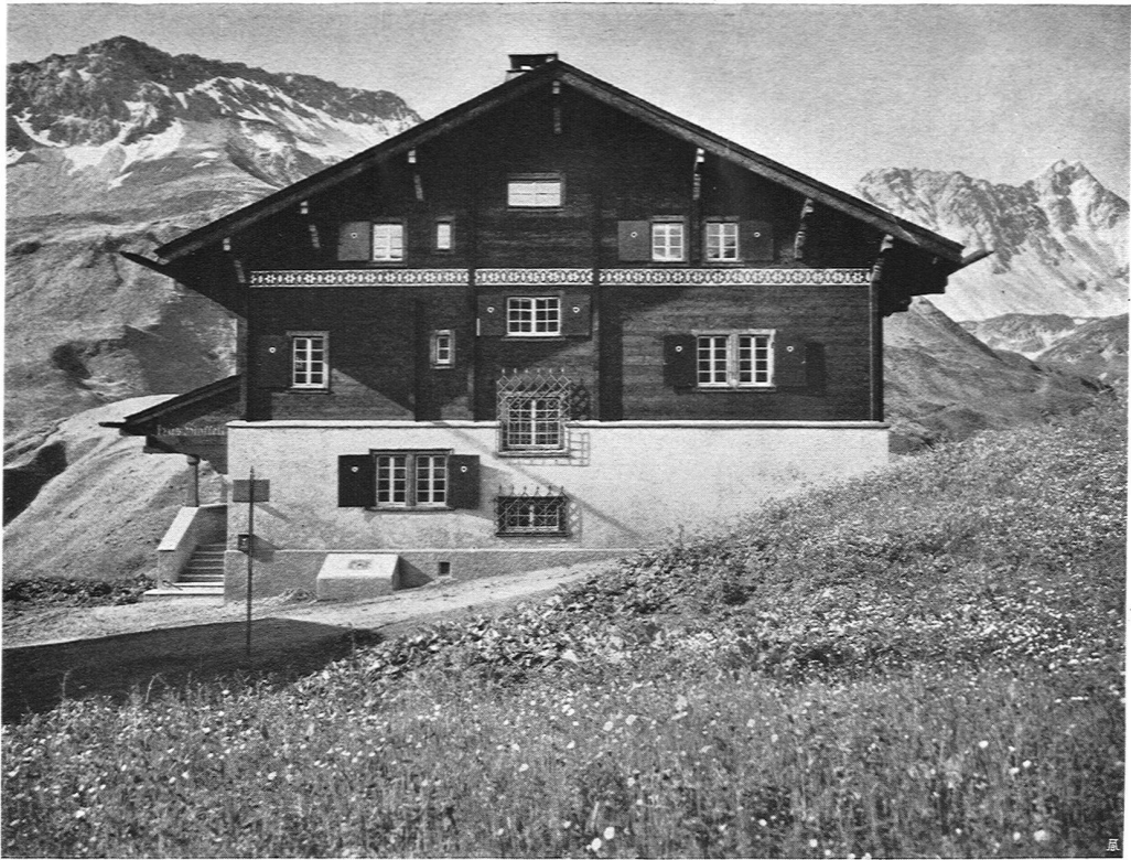
Hus Stoffell, Inner-Arosa, Ansicht von der Straße her
