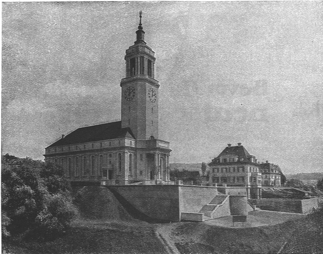
NEUE KIRCHE UND PFARRHAUS IN ZÜRICH-FLUNTERN
