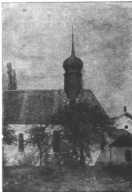
KAPELLE SPREITENBACH (AARG.), DACHREITER IN ETERNIT, GESCHLAUFTE DECKUNG, KUPFERBRAUN
