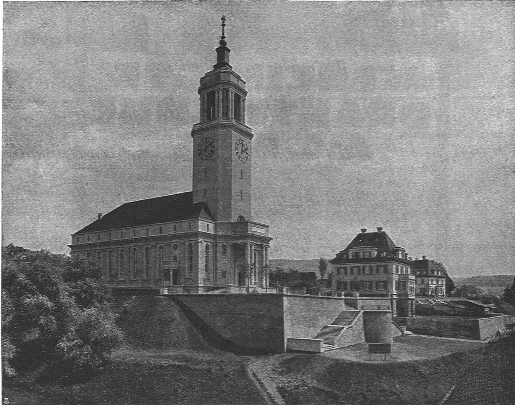
NEUE KIRCHE UND PFARRHAUS IN ZÜRICH-FLUNTERN
