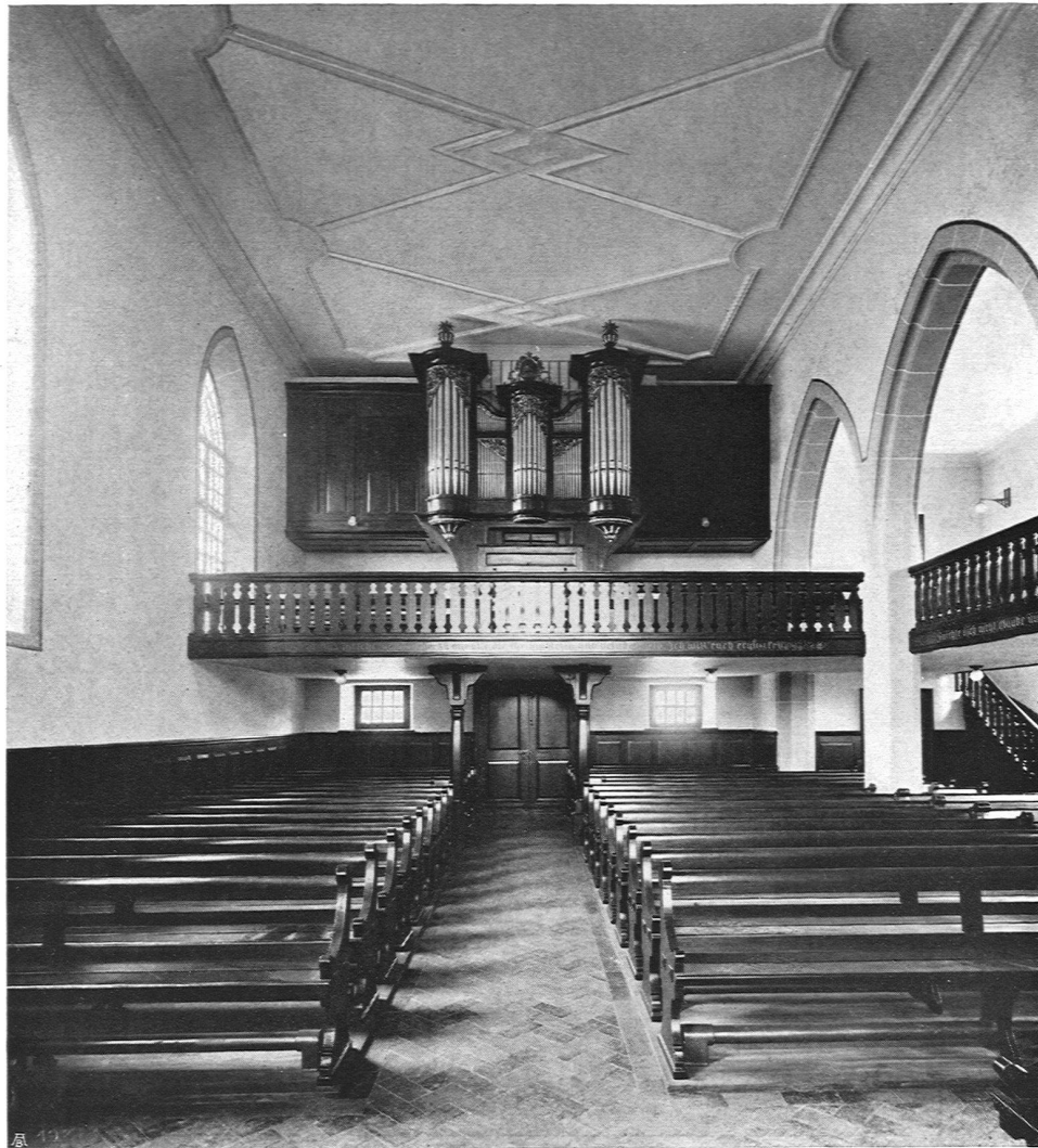
Kirche in Kölliken nach der Renovation, Architekt Fr. Haller S.W.B. in Kölliken i. F. Ulrich & Pfister Architekten S.W.B., Zürich. Inneres: Decke und Wände weiß mit braunroter Bordüre, Orgelempore und Bänke braun gestrichen, Bodenbelag rote Lausener Platten, Spruch am Fuß der Orgelempore in Eichenholz geschnitten von Carl Fischer, Bildhauer S.W.B., Zürich, Orgelumbau Goll & Co., Luzern
