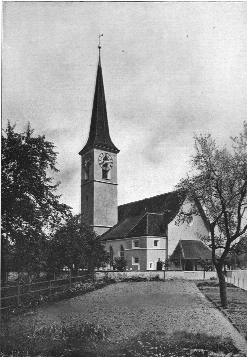
Kirche in Kölliken (Aargau). Renovation durchgeführt von Arch. Friedr. Haller S. W. B., Kölliken i. F. Ulrich & Pfister, Architekten S. W. B., Zürich. Ansicht vom Dorf her
