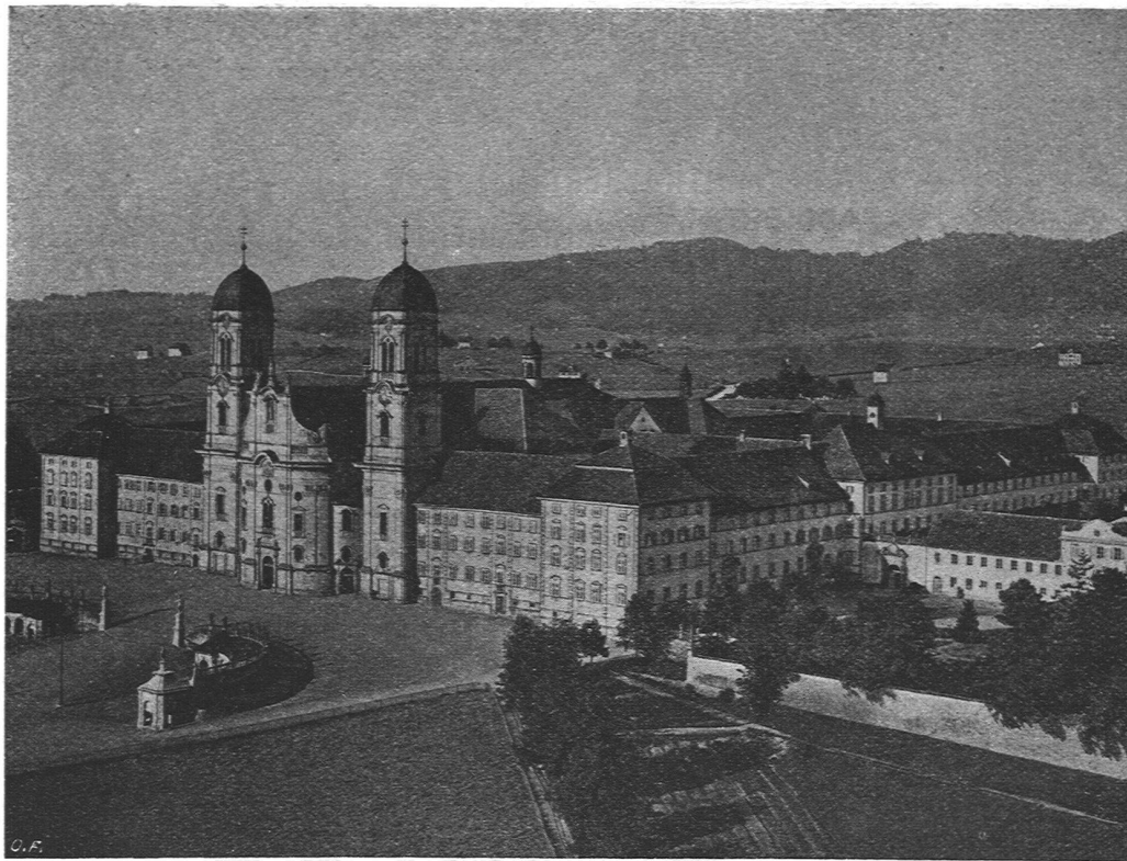
KLOSTER EINSIEDELN, FERN-WARMWASSERHEIZUNG IN SÄMTLICHEN GEBÄUDEN. DAMPFKOCKKÜCHEN-ANLAGE
