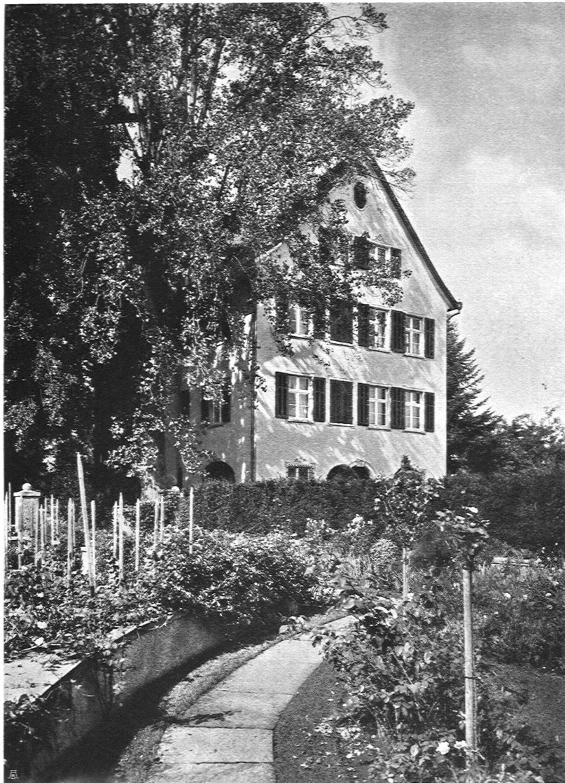
Umbau Schloß Hahnberg ob Arbon. Arch. Alb. Fröelich B. S. A., Zürich. Ansicht von Südosten
