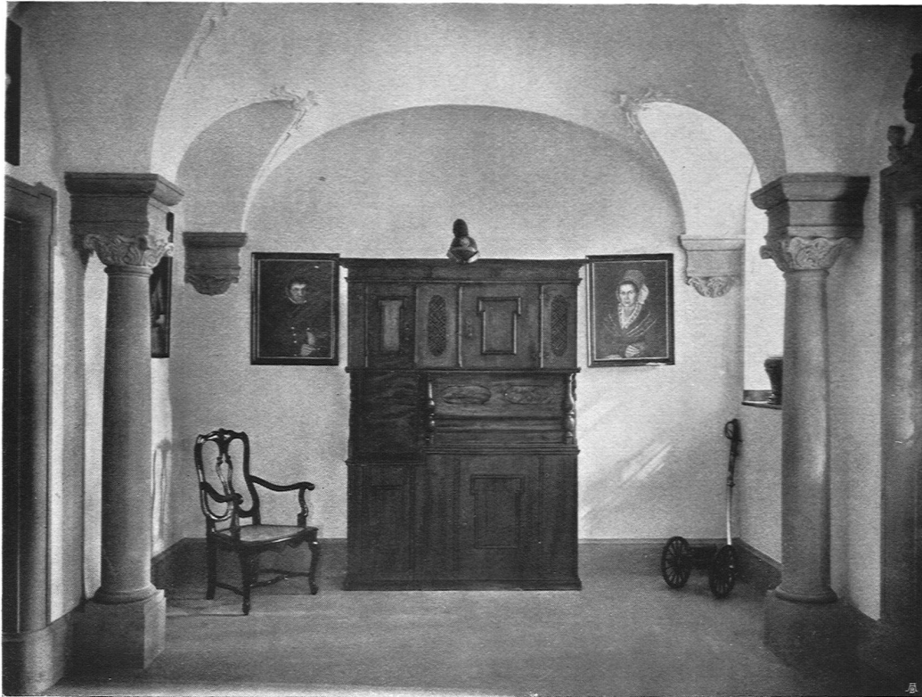
Umbau Schloß Hahnberg, Vorhalle zum Treppenturm
