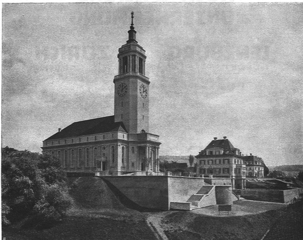
NEUE KIRCHE UND PFARRHAUS IN ZÜRICH-FLUNTERN
