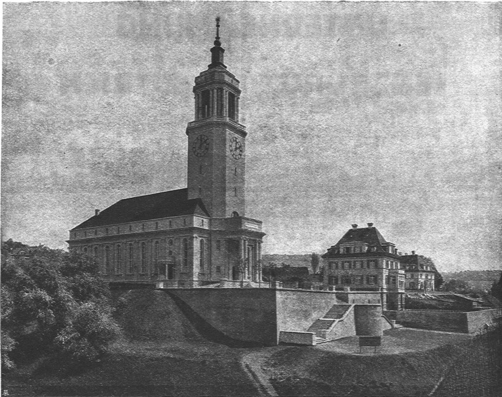
NEUE KIRCHE UND PFARRHAUS IN ZÜRICH-FLUNTERN
