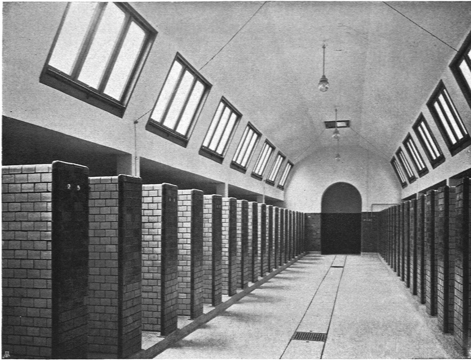
Untergeschoß, Wannensäler der Bad- und Speiseanstalt. Spaltblender im Gang blau, in den Kojen weiß, Wände und Decke weiß
