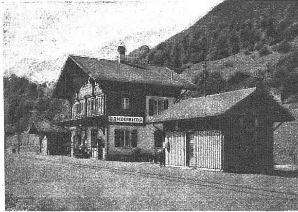
STATION DER BRIENZERSEEBAHN, ETERNIT-DOPPELDACH, KUPFERBRAUN
