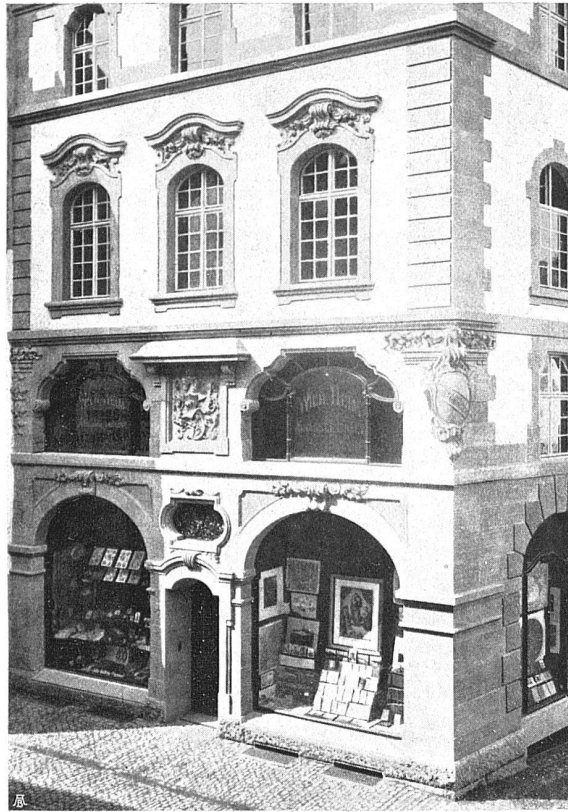
Geschäftshaus an der Freiestraße, Basel
