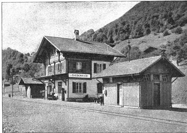
Station der Brienerseebahn
