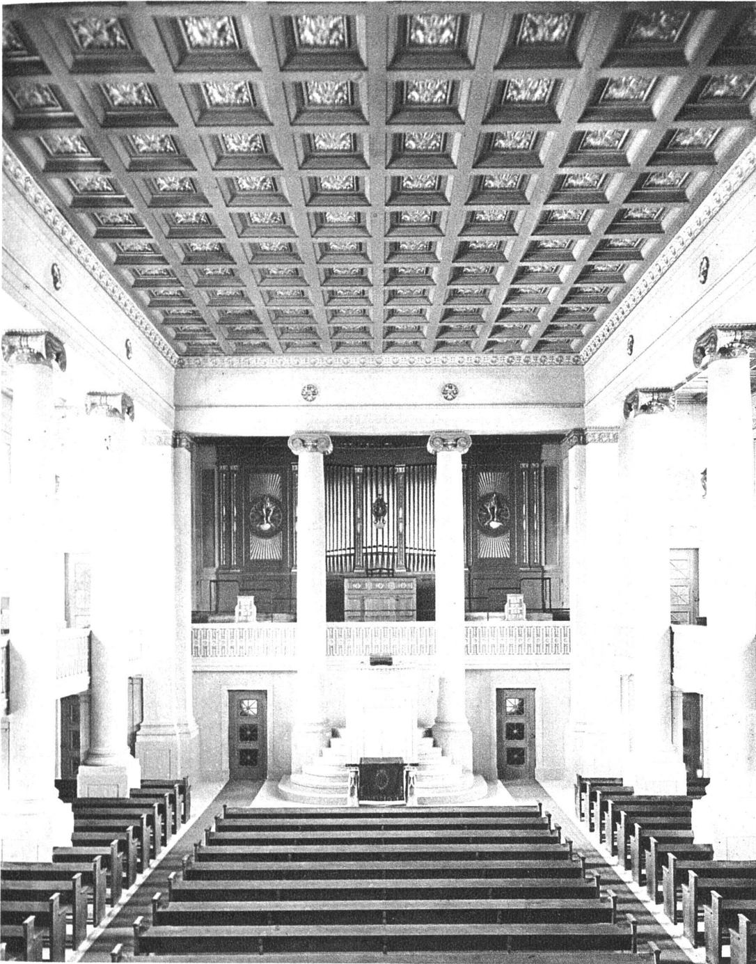
ABB. 10. INNERES, GESAMTANSICHT AUSFÜHRUNG DER DECKE UND DES ORGELGEHÄUSES, SCHREINERARBEITEN: BAUGESCHÄFT ALB. SCHNEIDER & CO., MUESMATT DER PLASTIK: BILDHAUER POCETTI, DES ORGELWERKES: KUHN IN MÄNNEDORF DER MALER- UND STUCKARBEITEN: DE QUERVAIN, SCHNEIDER & CO., DER PLASTIK: BILDHAUER POCETTI AUSFÜHRUNG DER BÄNKE VON BAUMGARTNER & CO., BERN
