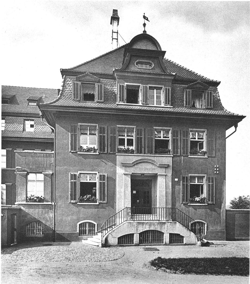
ABB. 17 KARL BURCKHARDT, ARCHITEKT B. S. A., BASEL (FIRMA BURCKHARDT, WENK & CIE.) ANSTALT „MOOSRAIN“ IN RIEHEN SEITLICHER FLÜGEL MIT HAUPTINGANG
