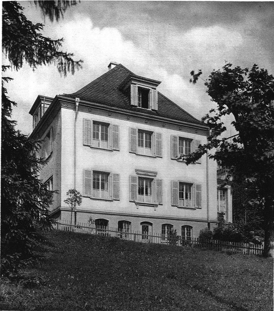
ABB. 8 PFARRHAUS ZÜRICH-UNTERSTRASS ANSICHT VON DER SEITE Phot. E. Linck
