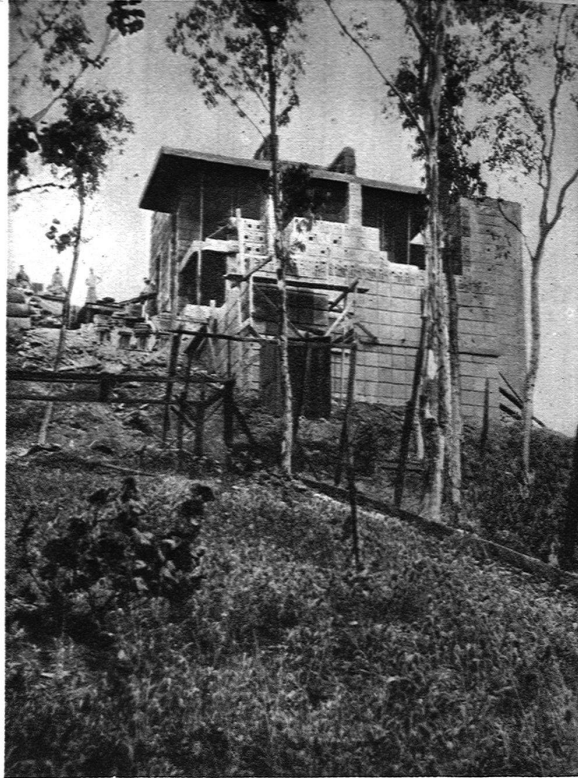
WOHNHAUS IN HOLLYWOOD, KALIFORNIEN Aufnahme während des Baues (Pläne Seite 145)
