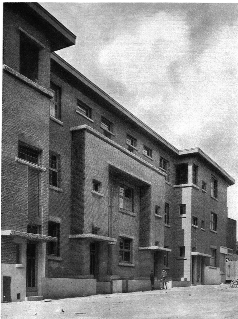
VICTOR BOURGEOIS / MIETHAUSGRUPPE AN DER »RUE DU CUBISME«, KOEKELBERG-BRÜSSEL (Pläne auf Seite 274)
