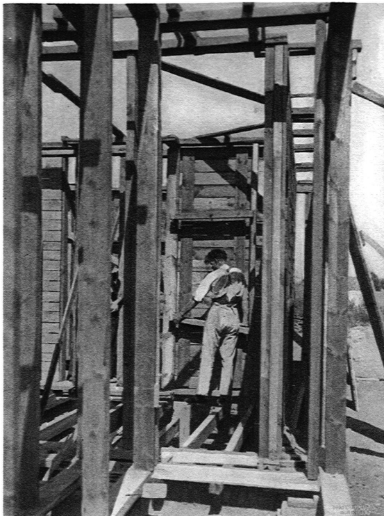
AUS DEM FILM »LA CITÉ MODERNE« HAUSBAU
