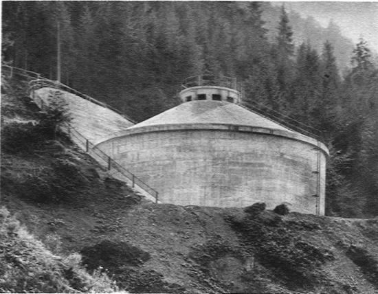
17. ZYLINDRISCHER WASSERBEHÄLTER DES WASSERSCHLOSSES REMPEN
