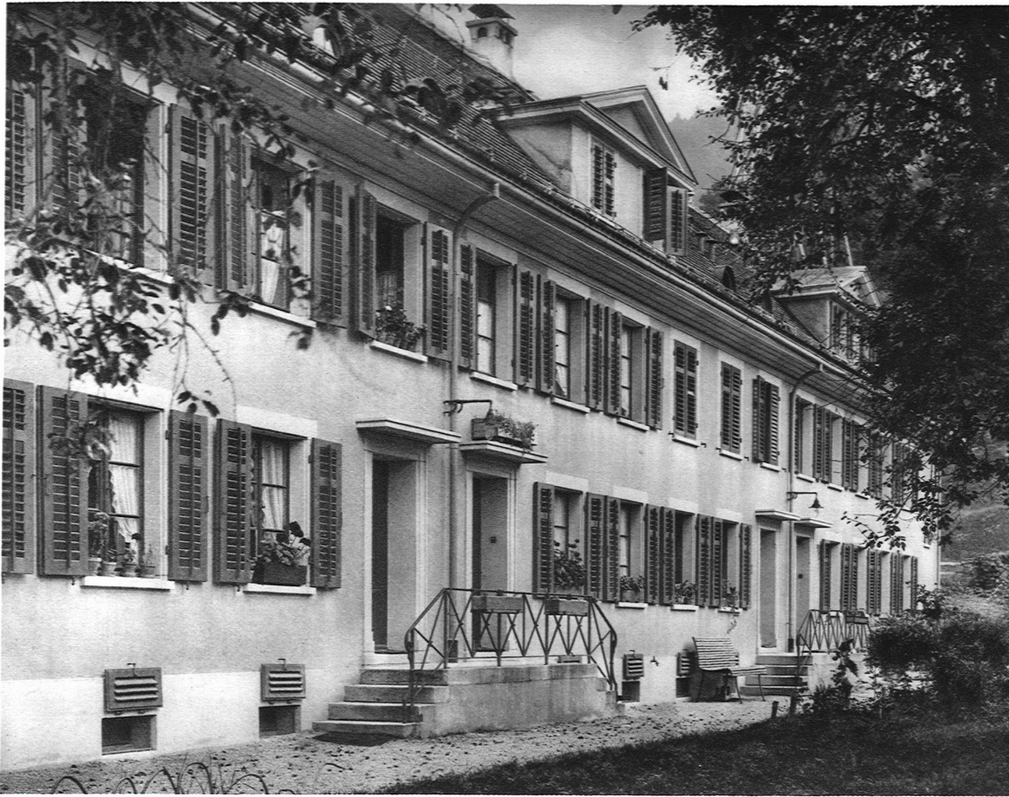
39. WOHNKOLONIE REMPEN / ARCHITEKTEN GEBR. BRÄM B.S.A., ZÜRICH Einfamilien-Reihenhäuser
