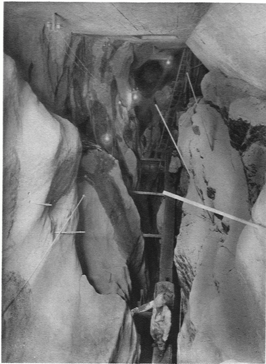
10. STAUMAUER SCHRÄH / DIE AUSGERÄUMTE EROSIONSRINNE DER WÄGGITALER AA
