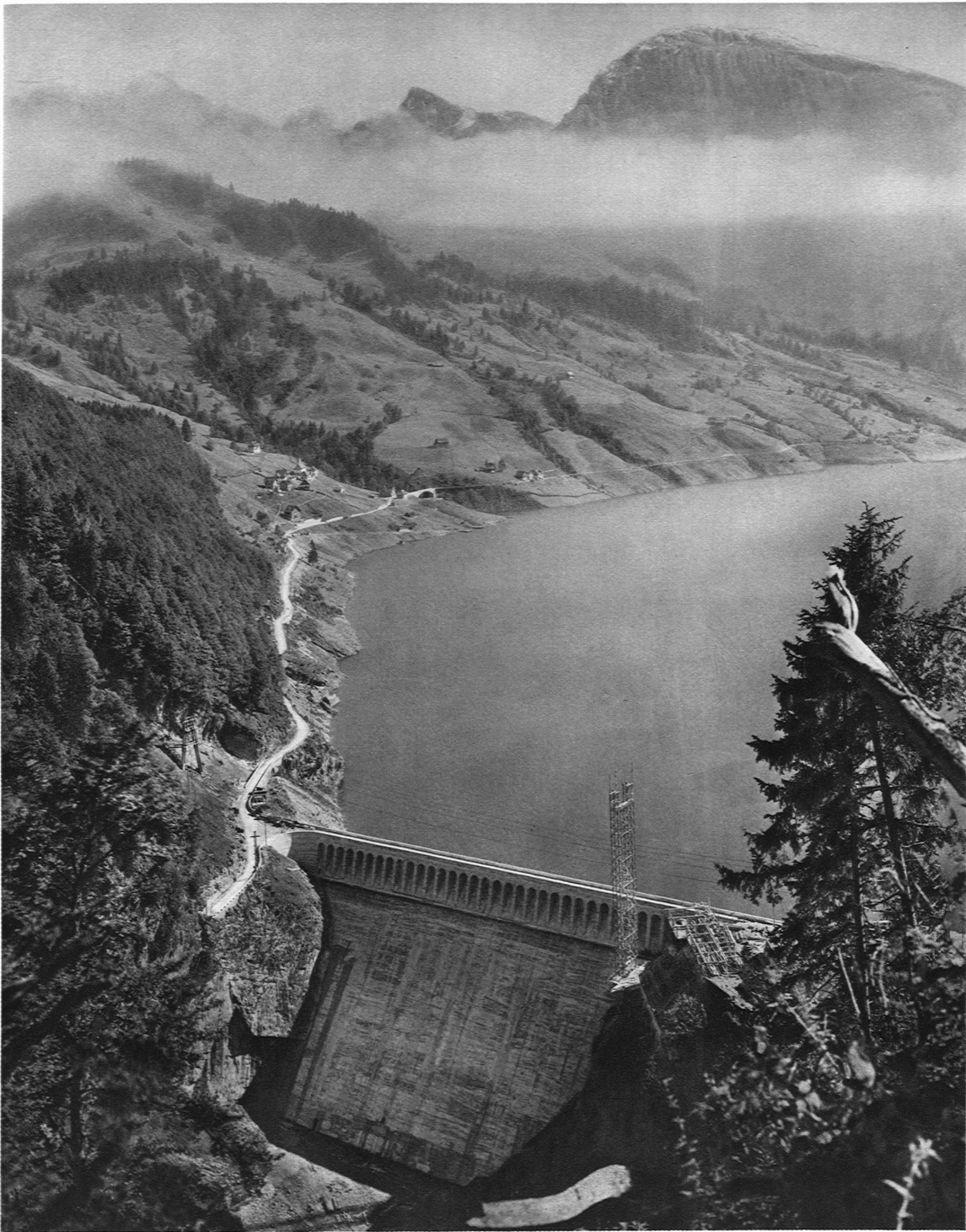
52. BLICK VOM SCHRÄHRÜCKEN AUF DIE STAUMAUER UND AUF NEU-INNERTHAL ARCHITEKTONISCHE GESTALTUNG DER STAUMAUER DURCH GEBR. PFISTER, ARCHITEKTEN B.S.A.
