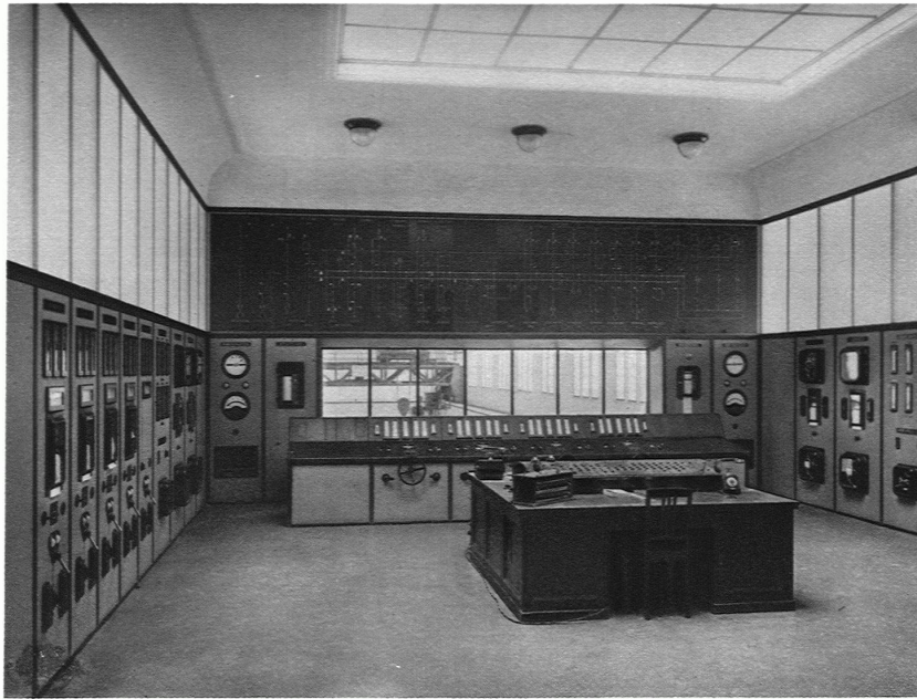
34. ZENTRALE SIEBENEN / MASCHINENHAUS / KOMMANDORAUM ARCHITEKTEN GEBR. BRÄM B.S.A.
