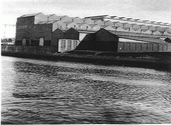
DIESELMASCHINENFABRIK DER SCHIFFSWERFT HARLAND & WOLFF LTD., GLASGOW Eisenkonstruktion, Wellblechwände, Glasdächer Phot. H. Wittwer
