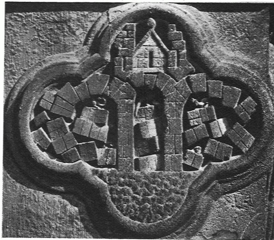
DEKORATIVES RELIEF AN DER HAUPTFASADE DER KATHEDRALE VON AMIENS
