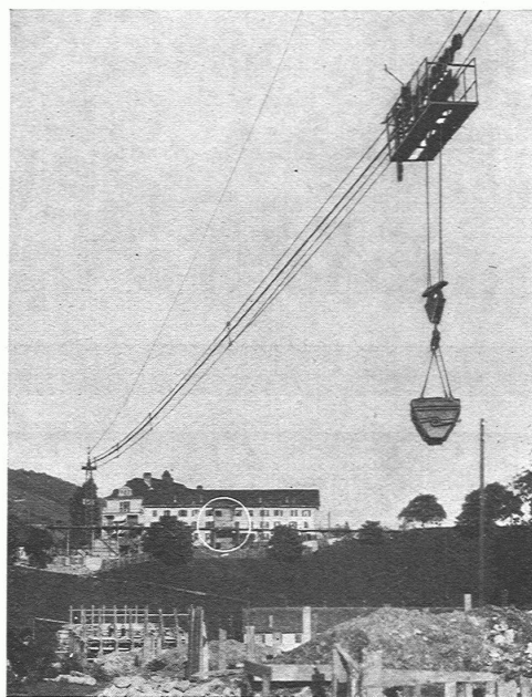
Kabelkran für die Brücke Baden-Wettingen
