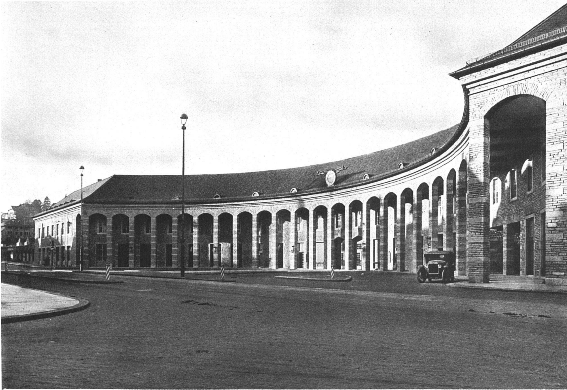
AUFNAHMEGEBÄUDE ENGE / ARCHITEKTEN GEBR. PFISTER Bahnhofvorplatz und Fassade
