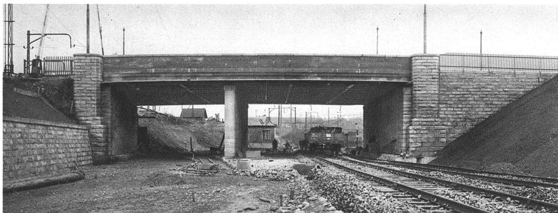
HOHLSTRASSENBRÜCKE von Süden gesehen
