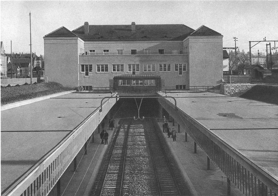
AUFNAHMEGEBÄUDE WIEDIKON Nordfassade mit Perrondächern und Stellwerk
