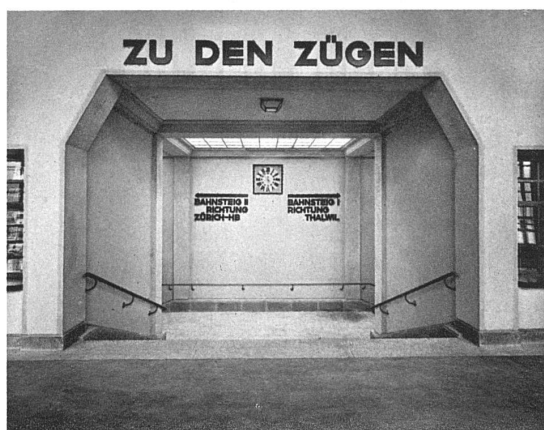
Abstieg von der Halle zu den Bahnsteigen
