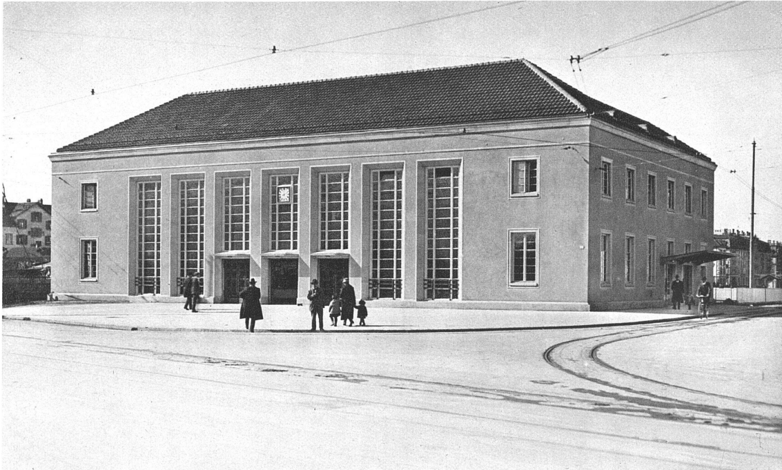
AUFNAHMEGEBÄUDE WIEDIKON / ERSTER »REITERBAHNHOF« DER SCHWEIZ ARCHITEKT B. S. A. HERMANN HERTER, STADTBAUMEISTER, ZÜRICH Hauptfassade von Südost
