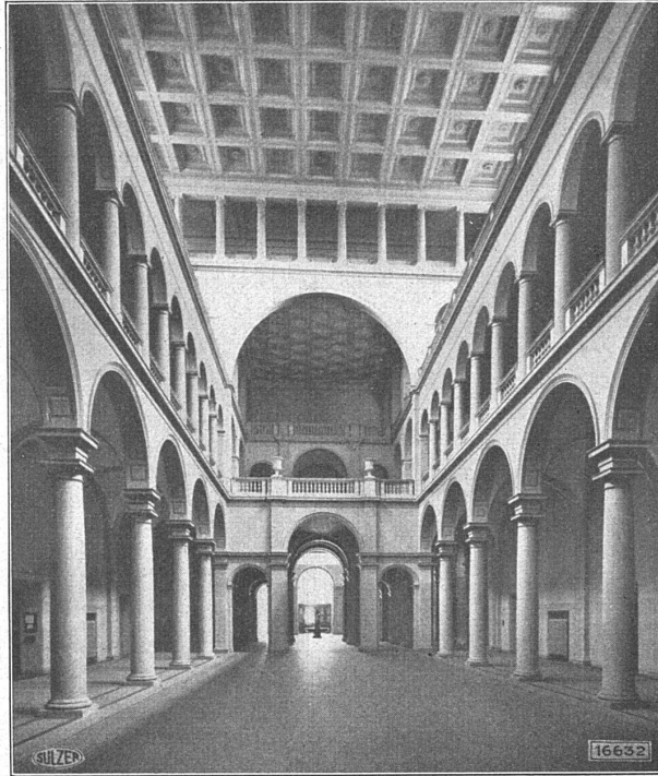
Eidg. Techn. Hochschule Zürich, ausgerüstet mit Sulzer-Pumpen-Warmwasserheizung.
