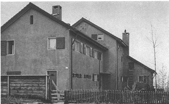
Zugang von der Strasse
