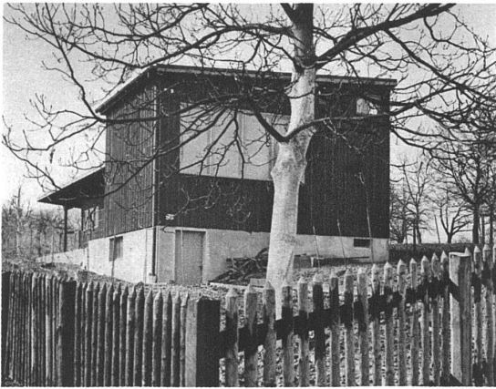
Zugang von der Strasse mit Atelier und Türe zur Waschküche
