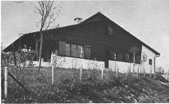
Zugang von der Strasse
