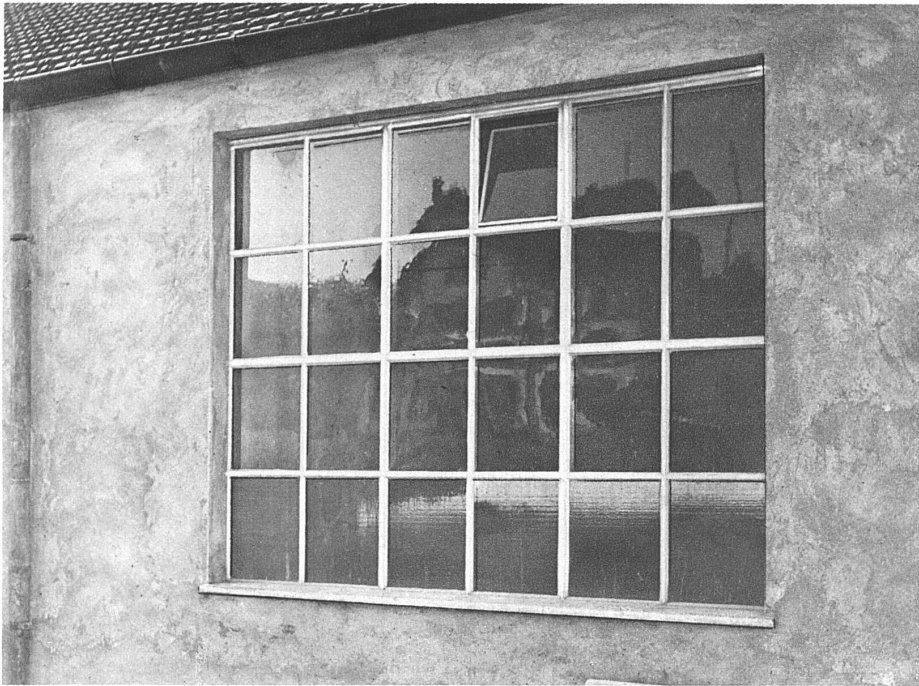
FENSTER AUS EISENBETON / AUSSENANSICHT MIT KLAPPFLÜGEL Aus der Fabrikanlage der Spezialbeton A.G. in Staad
