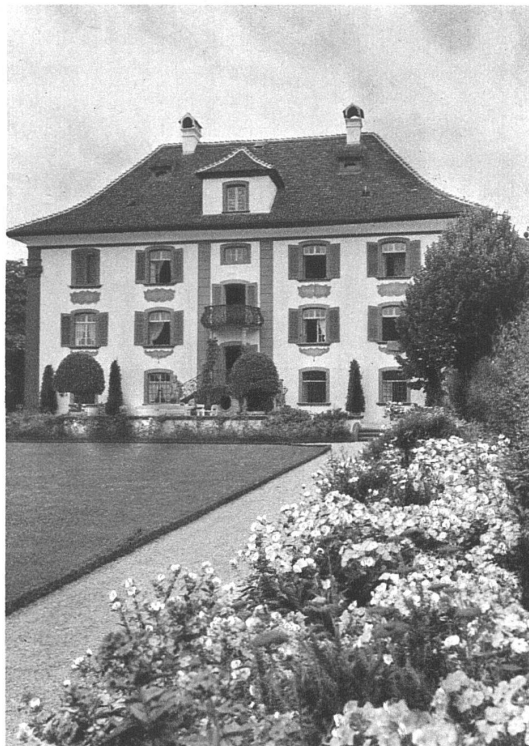
HAUS LINDE Das Parterre gegen das Haus gesehen
