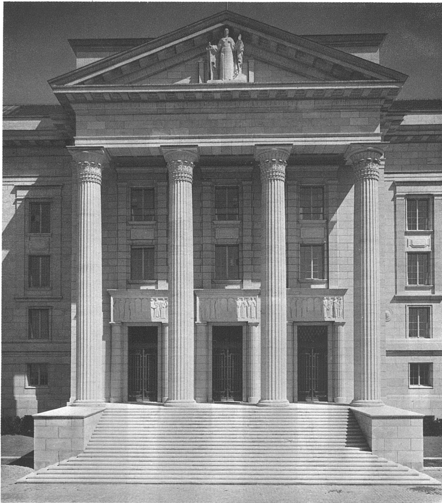
MITTELPARTIE DES BAUES MIT DEM HAUPTTEINGANG
