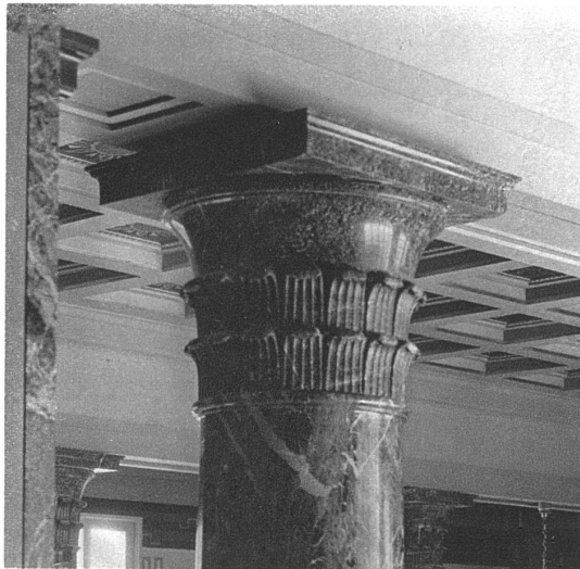
DAS GROSSE TREPPENHAUS Verde antico und St. Triphon
