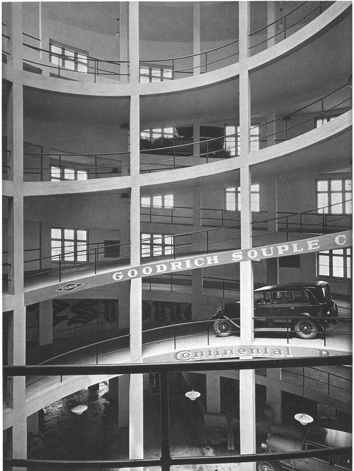
GARAGE C. SCHLOTTERBECK, BASEL / RAMPENTURM
