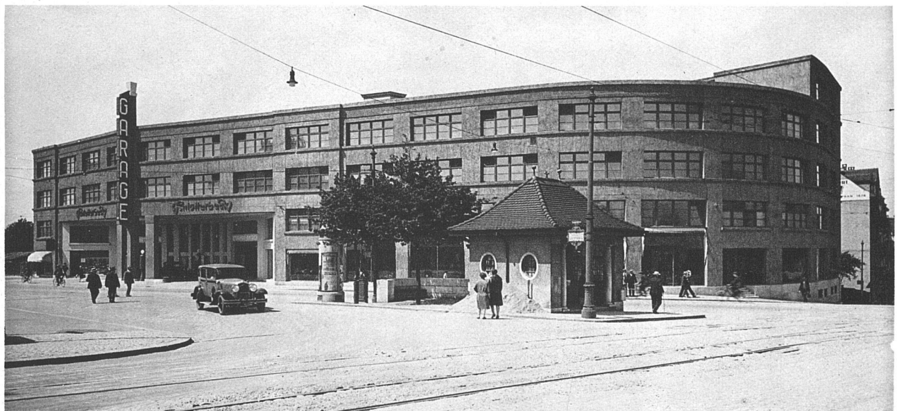
GESAMTANSICHT VON DER MARGARETHENBRÜCKE HER
