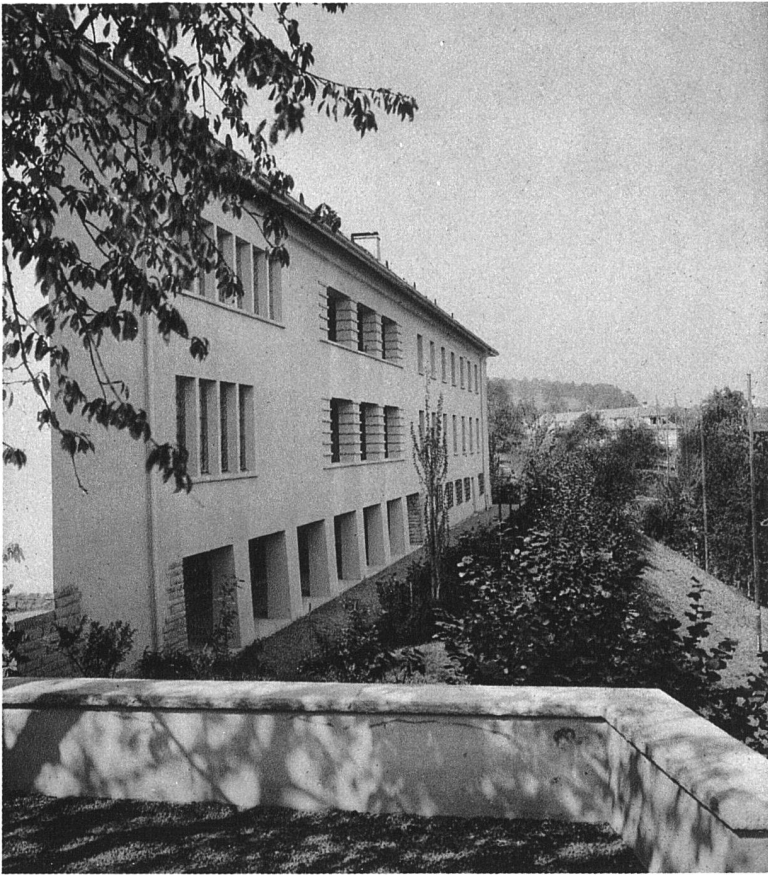
ALTERSHEIM WÄDENSWIL / TALSEITE
