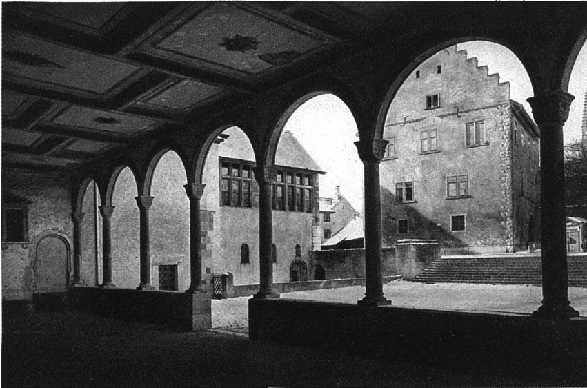
UMBAU ALLERHEILIGEN SCHAFFHAUSEN DIE MÜNSTERVORHALLE NACH DER ERNEUERUNG
