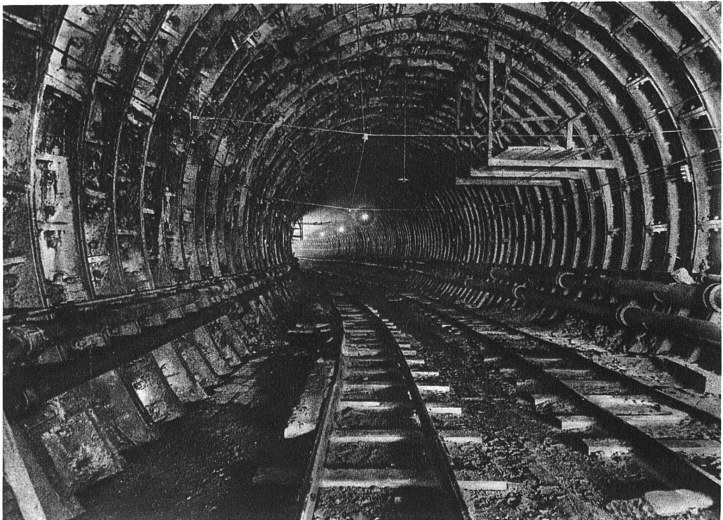
TECHNO-FOTOGRA- FISCHES ARCHIV UNTERGRUND- BAHN-TUNNEL
