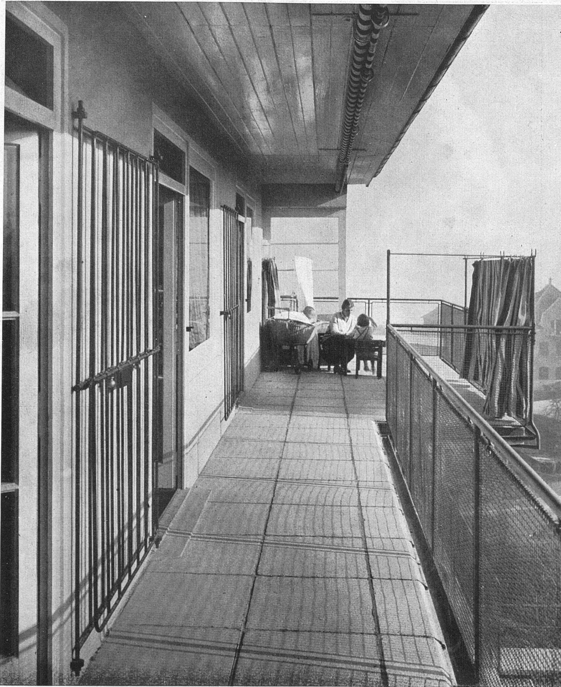
ARZTHAUS AN DER RENGGERSTRASSE, ZÜRICH WOHNTERRASSE GEGEN SÜDEN ARCH. MAX ERNST HAEFELI, ZÜRICH
