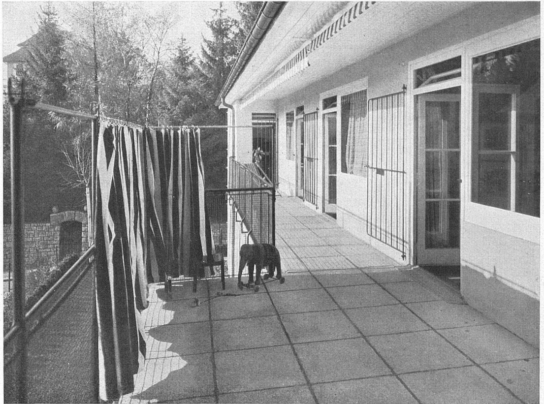
ARZTHAUS AN DER RENGGERSTRASSE, ZÜRICH WOHNTERRASSE GEGEN SÜDEN ARCH. MAX ERNST HAEFELI, ZÜRICH
