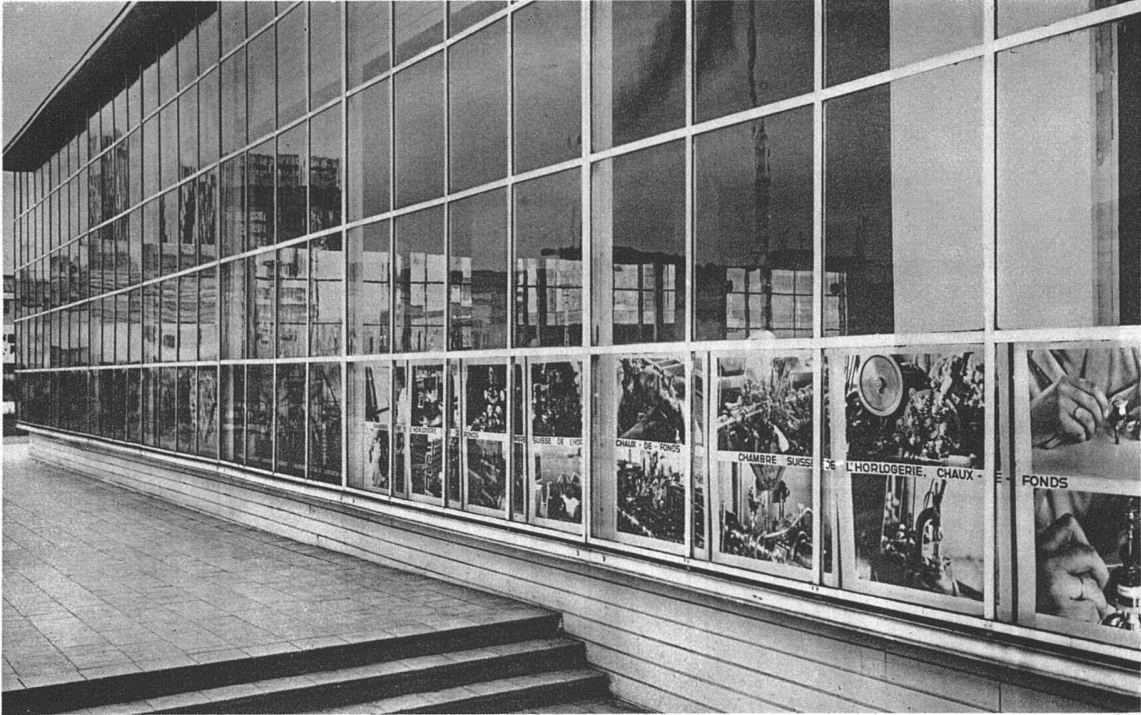
Schweizer Pavillon der Ausstellung Lüttich 1930 Architekt Hans Hofmann B.S.A. und S.W.B., Zürich Beschriftung und Photofries der E.T.H. von Walter Käch, Graphiker S.W.B., Zürich Die vor den Stützen frei aufgehängte Glaswand, mit einem Fries von Photos aus den zum Teil im Pavillon nicht vertretenen schweizerischen Industrien (Wehrli-Verlag, Kilchberg) unten: Eingang, rechts die gedeckte Passage mit den Stühlen als Ruheraum
