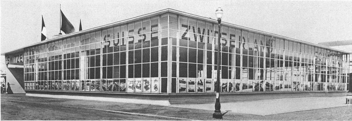
Südostecke und Umgebung des Pavillons unten: Nordostecke
