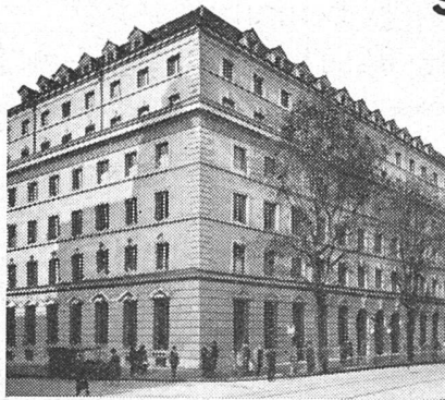
VOLKSBANK ZÜRICH, ARCHITEKTEN HONEGGER & MOSER, ZÜRICH
