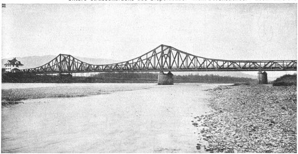
Strom-Brücke aus Stahl für schweren Verkehr. Wirkt durch die Eleganz der Linienführung. Grosse Spannweiten — 93 Meter! Wenig Pfeiler. Beim Bau minimale Versperrung des Flusses durch Gerüst-Einbauten. Vorteilhafte Anpassung an die Umgebung. Auskunft über den Stahlbau erteilt
