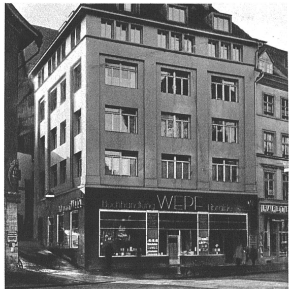
Nach dem Umbau
