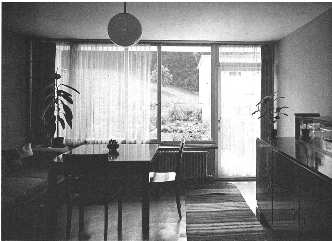
Wohnzimmer Holzschiebefenster mit ungeschliffenem Spiegelglas («Similiglas»)
