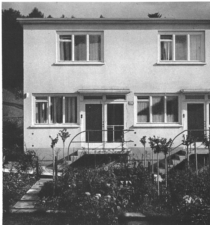
Typ D Rückseite (Eingangsseite) Abgetrennte Südnischen: 1,20 m breite Drahtglaswände, 3,20 m tiefer Plattenbelag vor der ganzen Hausbreite, 1,80 m weit ausladende Markisen
