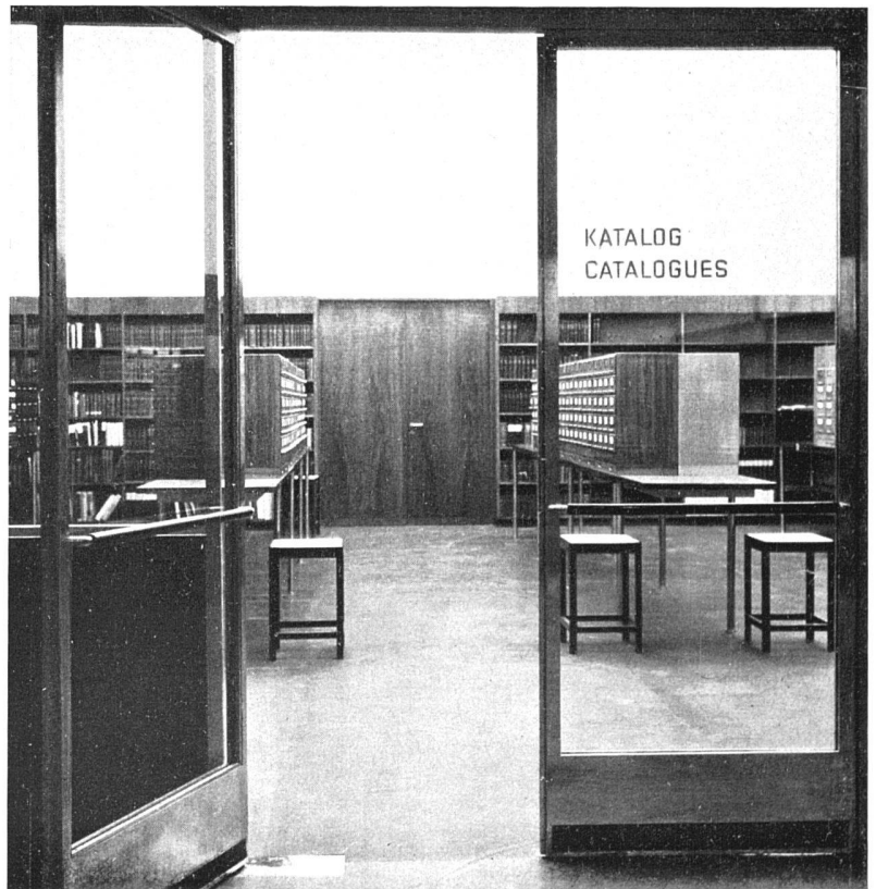
Blick aus dem Warteraum in den Katalogsaal
