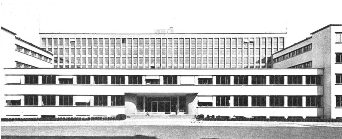
Mittelbau und Haupteingang von Süden, dahinter das Büchermagazin
